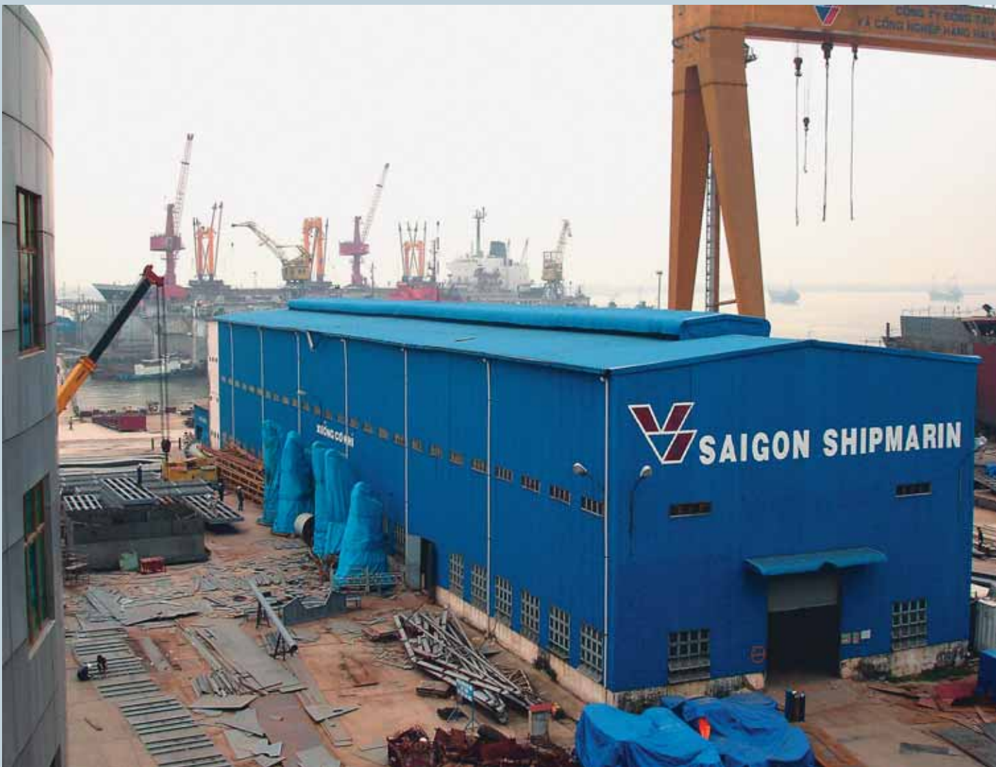
■ Überall Modernisierung Werft und Baustelle zugleich
